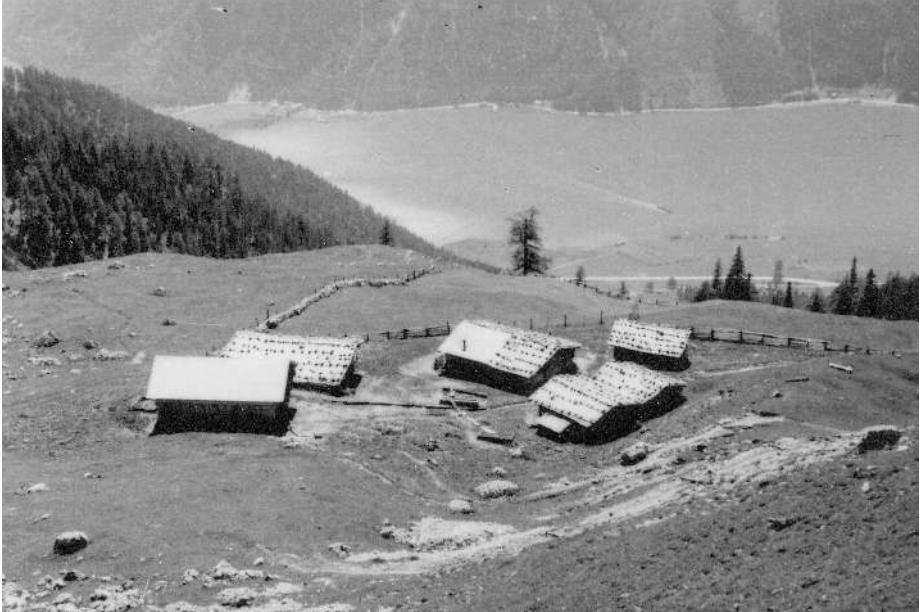
Dalfazalm im Achental. Der Unterschied zwischen den alten und neuen Gebäuden ist durch die Art der Almdächer sichtbar. Verschiedene Zaunformen am großen Almanger, um 1948 (Foto: Ludwig Sölder, 1949; Foto: Bildarchiv Georg Jäger).
